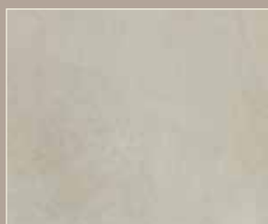
Le béton d'accumulation (standard) devrait recevoir un traitement de surface
